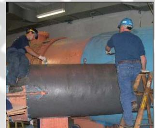
*METALCLAD<sup>®</sup> DuraWrap<sup>®</sup>* Puede ser aplicado en el interior y en el exterior de tuberías y otros equipos para así sellar y fortalecer estos componentes. Cuando se aplica a las paredes interiores de tuberías subterráneas o de difícil acceso *METALCLAD<sup>®</sup> DuraWrap<sup>®</sup>* puede reparar y restaurar de forma efectiva la integridad de las tuberías sin la necesidad de realizar excavaciones y reemplazos costosos.
