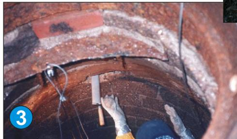
3. Se limpia la ruptura de mortero suelto y se aplica WP para instantáneamente detener la gotera, formando un tapón a prueba de agua...
